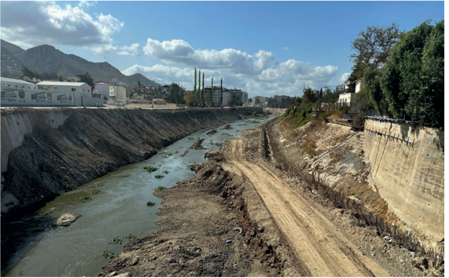
Asi Nehri, Köprü üzerinden Atatürk Parkına Bakış / Foto: İrem Aydemir, 2025
