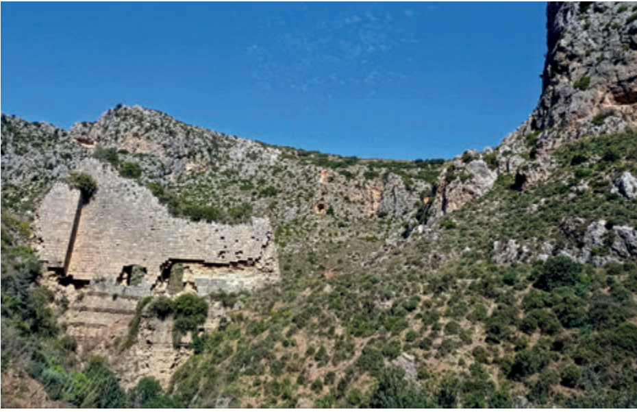
Demir Kapı Foto: Mert Aslanyürek, 2025
